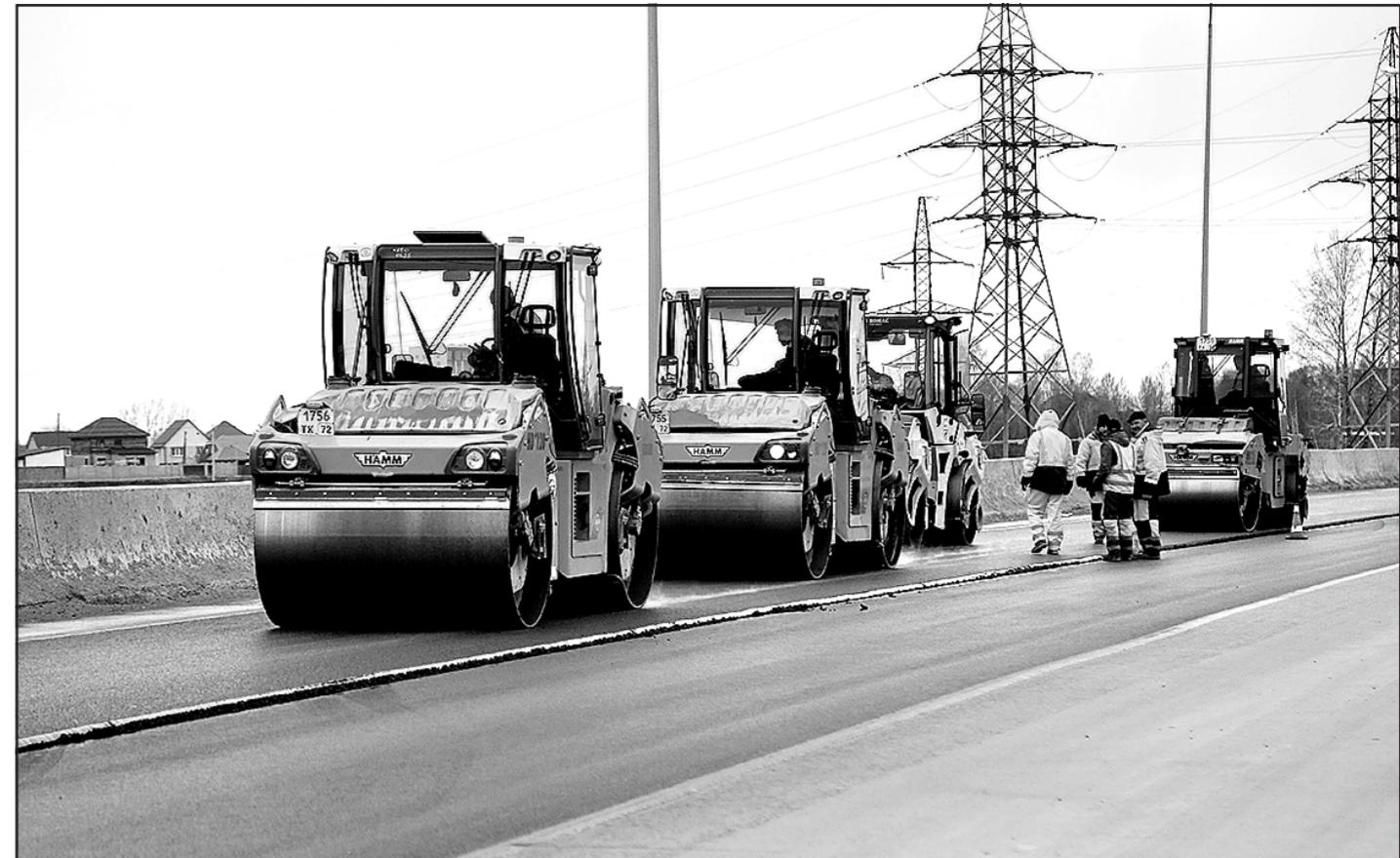
части, за время эксплуатации здесь образовалась значительная колея. Плюсы от ремонта данного участка дороги очевидны: автолюбители получили гладкую и ровную дорогу, а пассажиры — еще и безопасно расположенный остановочный пункт.
